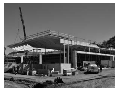
Holzbaumontage beim ASZ Vorderland
