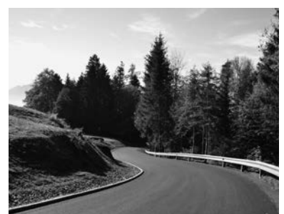
Die Furxstraße wurde in den Jahren 2017 und 2018 um rund 2 Mio Euro saniert.
