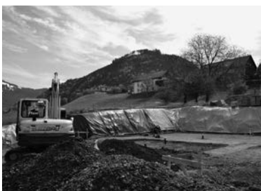
Baufortschritt Bodenplatte Wohnanlage Alpenländische Dafins
